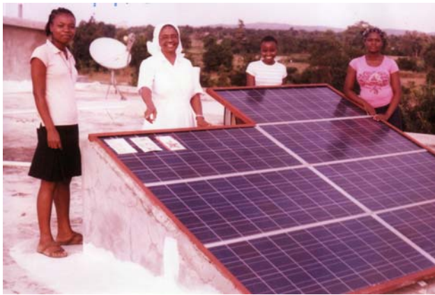
Placas solares instaladas gracias al proyecto
